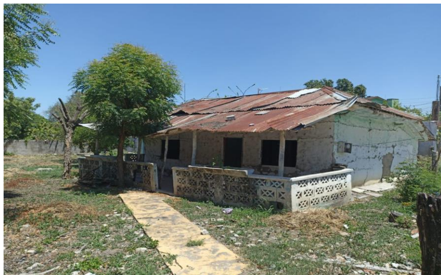
Figura 7. Fachada del inmueble en Ciudad Valles,
