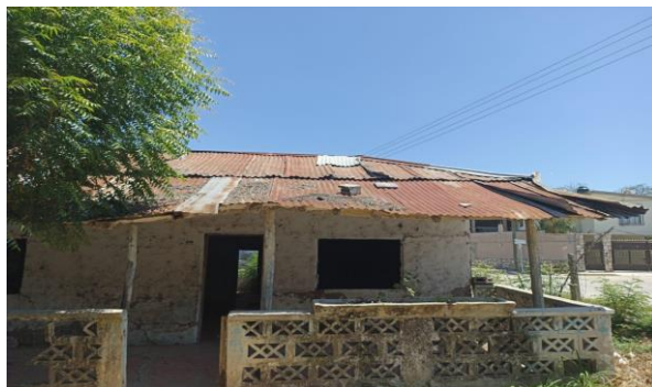
Figura 10. Área principal y lobby del inmueble
