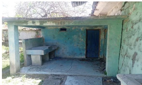
Figura 11. Área de baños del inmueble
